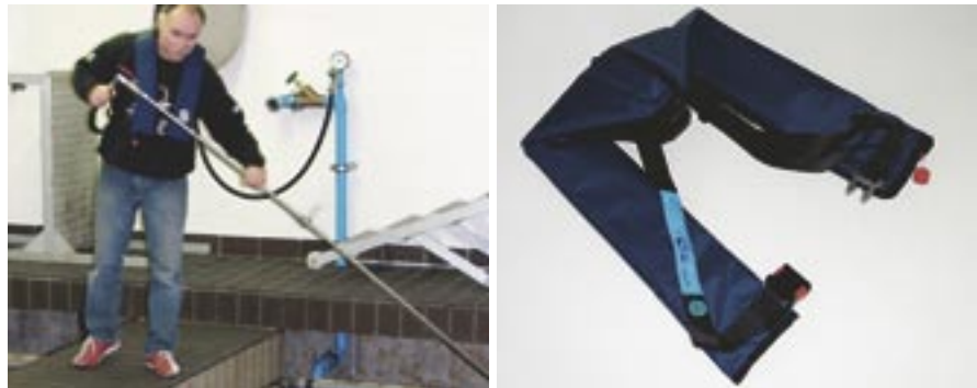
Reinigung der Filterbecken, neu mit Sicherheitsschwimmwesten
