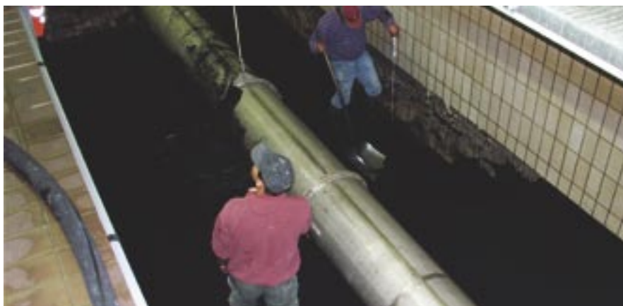
Arbeiten im Filterbecken
