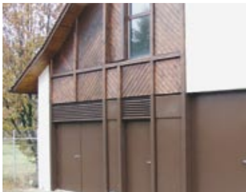
Eingang Pumpwerk Sonnenfeld
