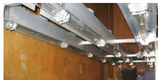
Einbau neue Glaskonstruktion
